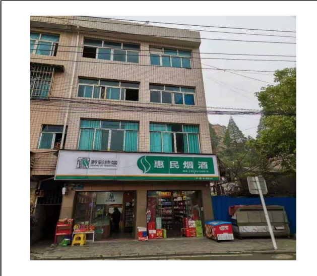
贵州省毕节市纳雍县茶林社区施工前证据保全
