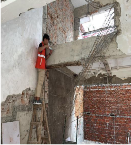
广州番禺区钟村街祈福新邨房屋安全鉴定
