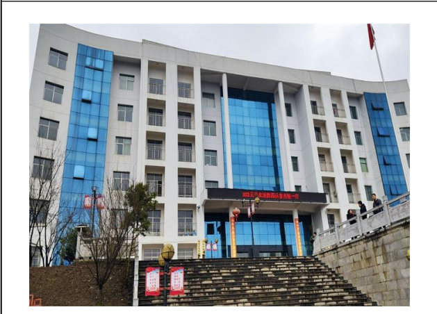
贵州省毕节市纳雍县维新人民政府办公大楼 结构可靠性检测鉴定
