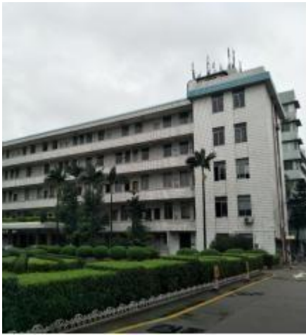
广州民航职业技术学院五层教学楼建筑 结构可靠性鉴定
