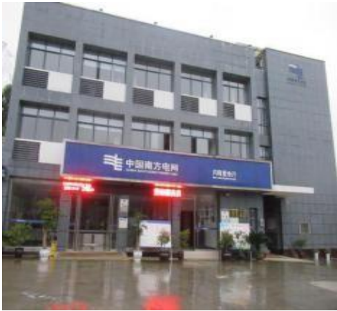
贵州省湄潭县兴隆镇兴隆供电所结构可靠性检测鉴定
