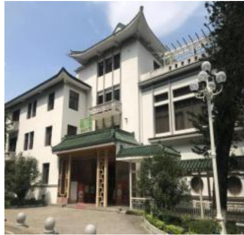
广州从化温泉宾馆湖滨大楼结构可靠性检测鉴定
