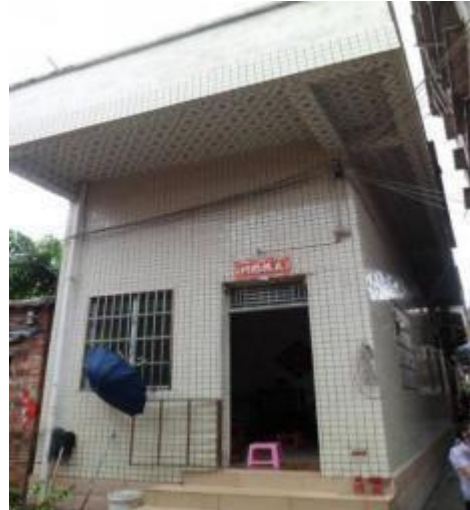
中铁十一局集团有限公司佛肇城际 GZZH-5 标段施工 周边房屋安全鉴定
