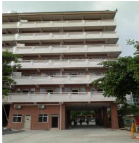
广雅实验学校学生宿舍楼房屋完损性鉴定
