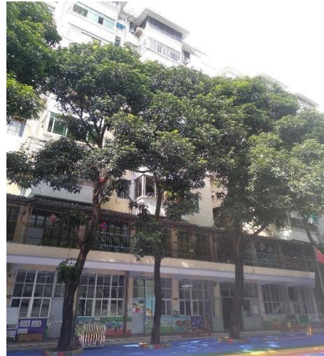
广州市海珠区江湾南幼儿园房屋安全鉴定
