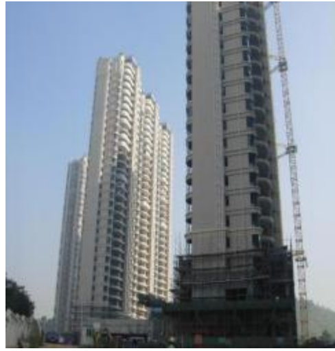
江门珠江国际新城 E1-E6 栋地下车库可靠性检测鉴定
