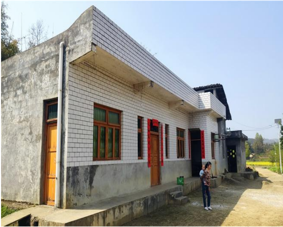
贵州省遵义市红花岗区新舟镇吴田村房屋 结构可靠性检测鉴定
