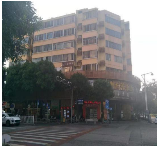
佛山市南海区瑞玥宾馆房屋安全鉴定
