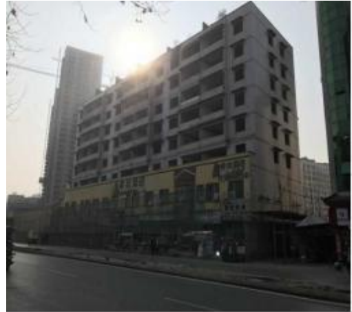
贵州省遵义市外环路田坝综合楼可靠性检测鉴定
