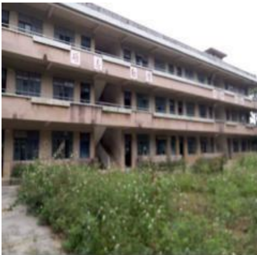
四会市罗源镇原罗源中学教学楼可靠性检测鉴定
