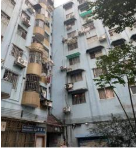
广州大道南绿翠园翠竹路电梯加装可靠性检测鉴定
