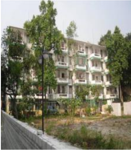
广州冶炼厂施工周边房屋安全鉴定
